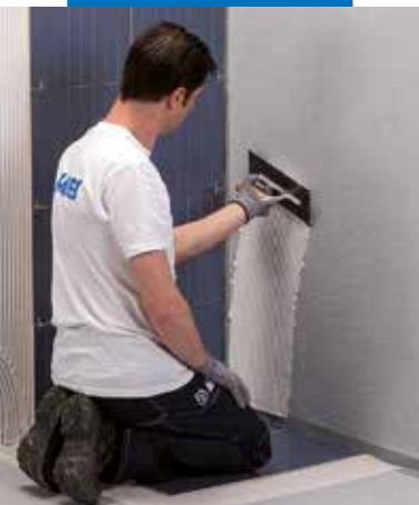
Posa di rivestimento con Keraflex Maxi S1
