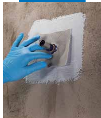
Applicazione di guarnizione per fori passanti di Mapeband PE 120 mediante Mapegum WPS
