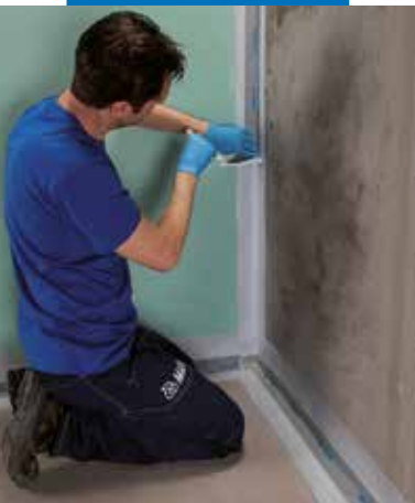
Applicazione di Mapeband PE 120 mediante Mapegum WPS
