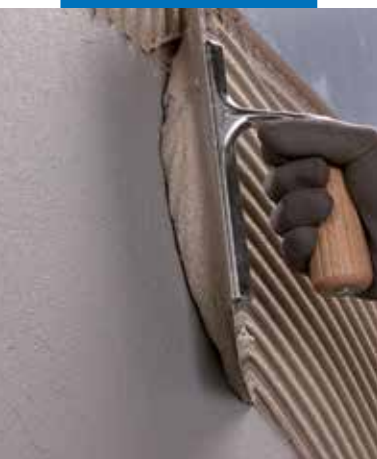
Posa di rivestimento con Ultramastic III
