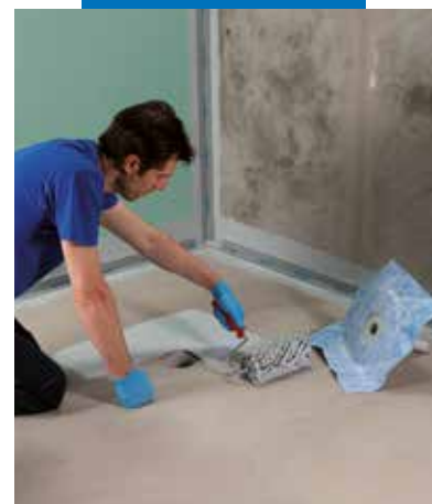
Applicazione di Drain Vertical mediante Mapegum WPS
